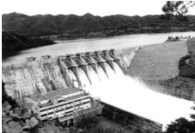
a) Nhà máy thủy điện sau đập
